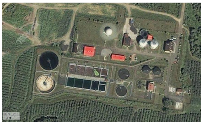
Rys. 2.1. Oczyszczalnia ścieków w Jaśle [5].
