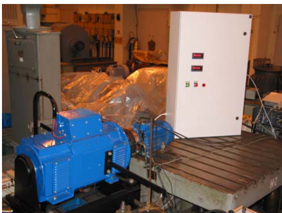
Rys. 29. Widok hamownicy prądu stałego z układem energoelektronicznym
