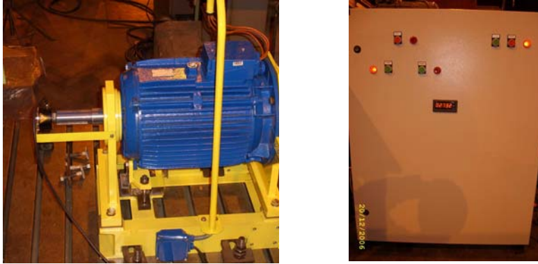
Rys. 30. Widok hamownicy prądu przemiennego z układem energoelektronicznym
