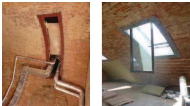
Rys. 1. Widok otworów w ceglanych sklepieniach walcowych wykonanych dla przewodów inżynierii sanitarnej (a) i okien połaciowych (b)
