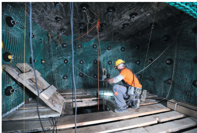
Rys. 6. Prace w szybiku „Geramb” (fot. R. Stachurski)
