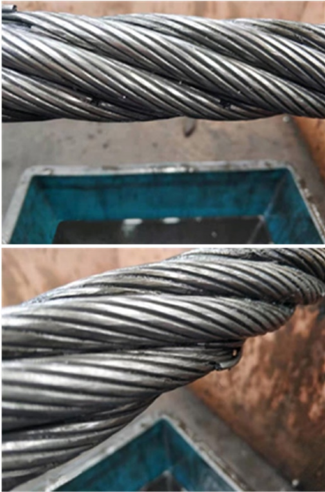
Fig. 3. Actual fracturing part of wire rope
