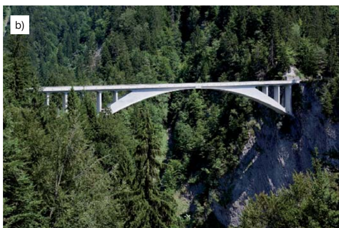
Fot. 1. Widok mostu: a) na rusztowaniach podczas napraw, b) współcześnie [1]
