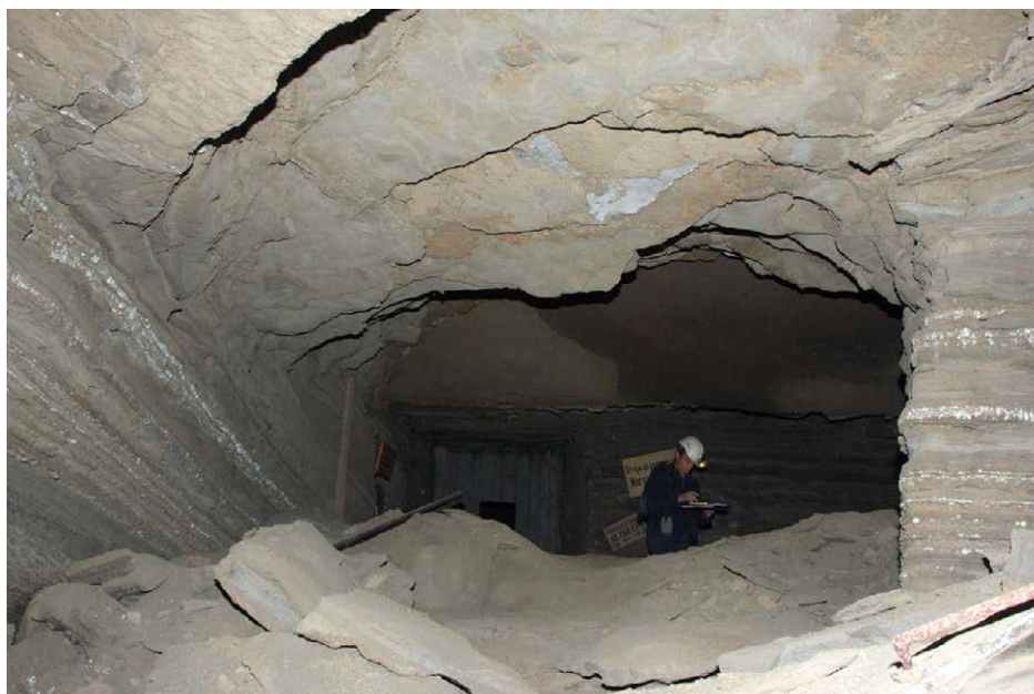
Ryc. 4. Obwał wyrobiska. Gruz skalny z obwału skał stropowych i ociosowych.
