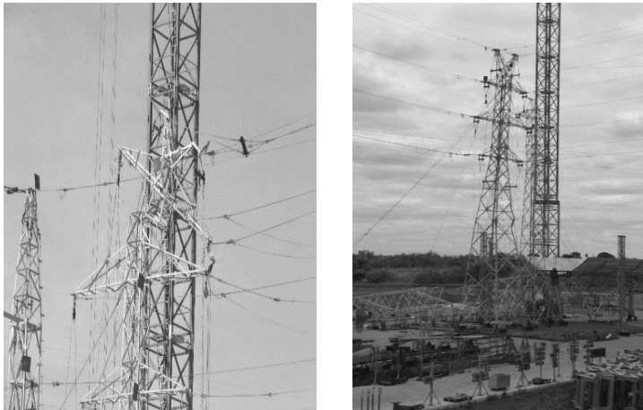
Rys. 6. Schematy zniszczenia słupów dwutorowych EN122 [7]
