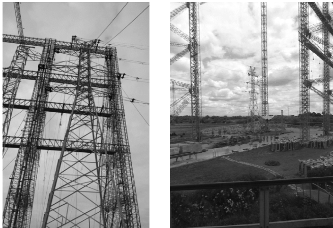
Rys. 3. Konstrukcje oporowe (z lewej) oraz widok ogólny poligonu badawczego (z prawej)
