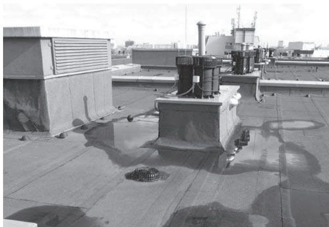
Rys. 8. Nasady kominowe na trzonach wentylacyjnych mechanicznej wentylacji niskociśnieniowej (hybrydowej)
