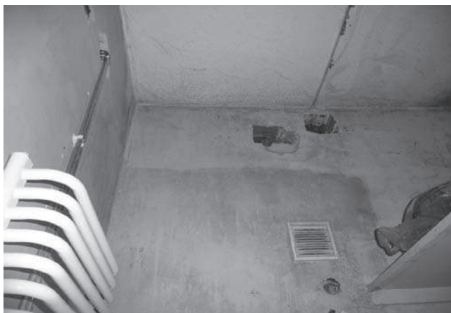
Rys. 7. Kratka wentylacyjna umieszczona bardzo nisko (120 cm od sufitu) wbrew obowiązującym regulom; z prawej strony ogniska pleśni
