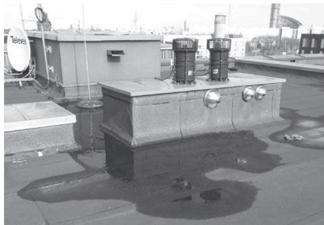
Rys. 8. Nasady kominowe na trzonach wentylacyjnych mechanicznej wentylacji niskociśnieniowej (hybrydowej)
