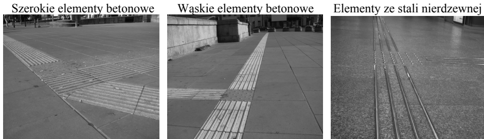
Rys. 3. Przykłady rozwiązań ścieżek dotykowych w Centrum Warszawy [fot. P. Gondek]
