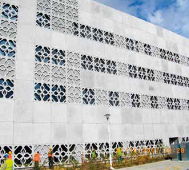
Fot. 2. Politechnika w Białymstoku, biblioteka, obiekt po oddaniu
