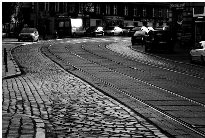
Rys. 9. Na ulicy 28 Czerwca 1956 r. nie można spełnić wymagań łącznie opisujących minimalne promienie łuków poziomych i pochylenie podłużne trasy [36]
