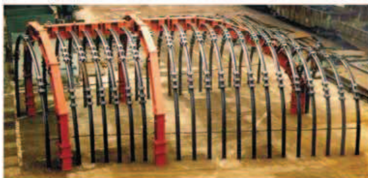
Rys. 16. Obudowa odgałęzienia pochylni Glinna Góra z przecinką odstawczą nr 2 w ZG „Sobieski” a) konstrukcja w trakcie próbnego montażu u producenta [5] b) widok belki stropowej łączącej portale oraz portal pomocniczy
