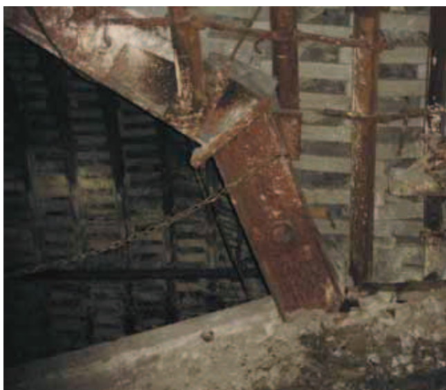
Rys. 10. Widok belek wspornika ze strony pochylni odstawczej. Widoczne wsporniki do posadawiania odrzwi uzupełniających.
