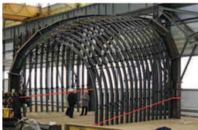
Rys. 8. Obudowa w trakcie montażu próbnego. (Liniami zaznaczono poziomy posadowienia odrzwi) Fig. 8. Support during the test assembly (the foundation levels of timbers are marked with lines)
