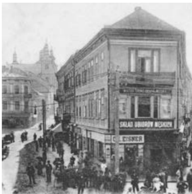
Rys. 9. Na pierwszym planie s up rozga ężny linii prądu sta ego przy zbiegu ulic Franciszkańskiej i Kazimierzowskiej; latarnia uliczna zawieszona na przewieszce pomiędzy budynkami; widok kówka z 1901 r. [10]
