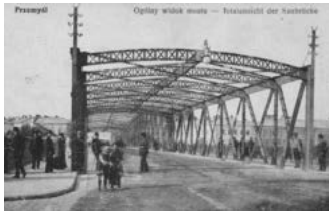
Rys. 8. Widok mostu drogowego na Sanie ok. 1909 r. na konstrukcji mostu widoczne wsporniki linii elektrycznej prądu sta ego dla Zasania, w sumie 6 obwodów; widoczna także latarnia oświetleniowa [10]
