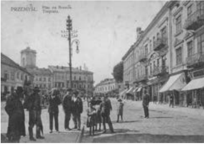
Rys. 10. S up przelotowy linii elektroenergetycznej prądu stałego 2x150 V z latarnią oświetleniową na Placu na Bramie 1910 r.[10]
