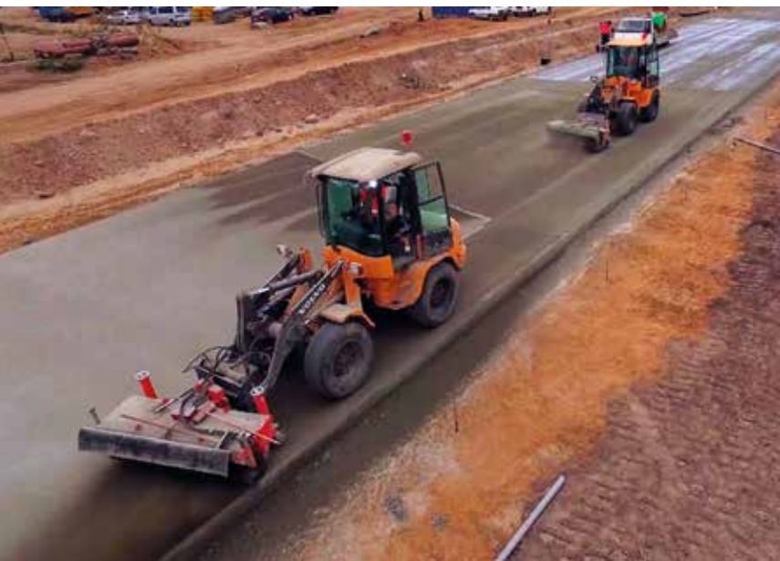
Fot. 4. Szczotkowanie wierzchniej warstwy nawierzchni cementowej
