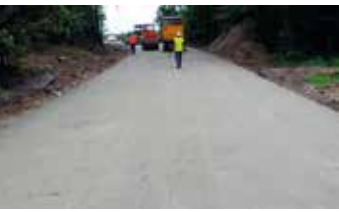
foto: CEMEX Infrastruktura
