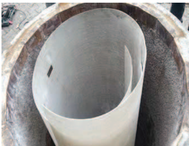
Rys. 1. Wkład panelowy przygotowany do zamontowania w studni
