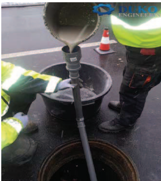
Rys. 2. Wypełnienie przestrzeni pomiędzy starą studnią a panelem żywicznym masą iniekcyjną
