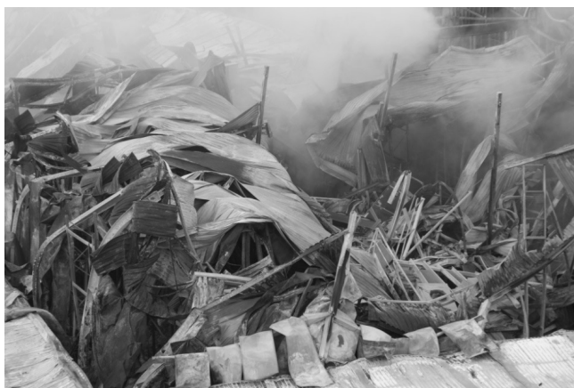
Ryc. 6. Widok zniszczonej w wyniku pożaru konstrukcji hali produkcyjno-magazynowej [2] Fig. 6. View of the construction of the production and storage hall destroyed by fire [2]
