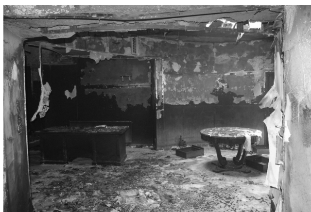
Ryc. 8. Zniszczenia części administracyjnej [2] Fig. 8. The destruction of the administrative part [2]
