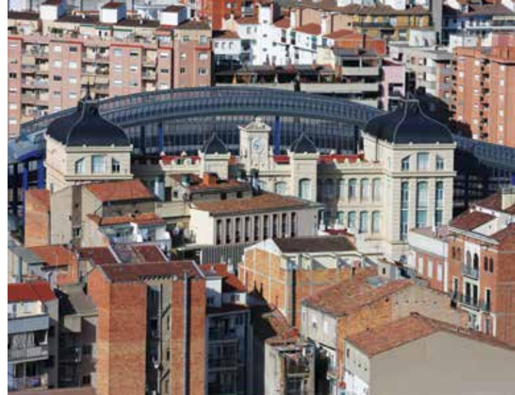
Widok na budynek dworca Lerida-Pirineos zlokalizowany w zwartej strukturze miasta. Fot. T. Bużalek
