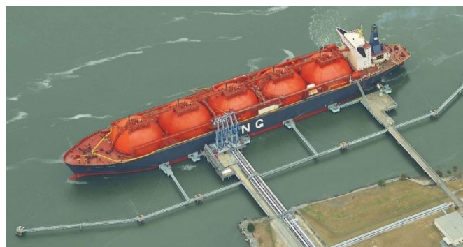
Rys. 1. Terminal Dawei LNG [6]
