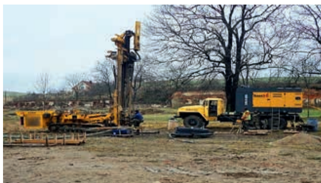
Ryc. 5. Całość zestawu urządzeń do wiercenia metodą dolnego młotka – sprężarka i wiertnica [11]
