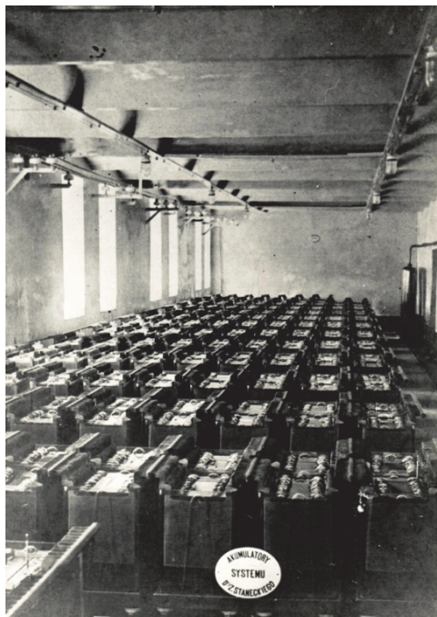
Rys. 2. Akumulatory systemu Z. Staneckiego na pierwszej Lwowskiej elektrowni prądu stałego.
