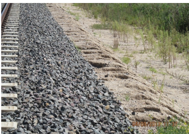
Rys. 4. Tor po modernizacji: brak rowu, splywy i bruzdy na ławie torowiska [fot. ze zbioru IK]
