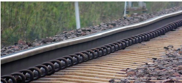
Rys. 6. Nierówności podłużne w pierwszym roku eksploatacji toru [fot. ze zbiorów IK]
