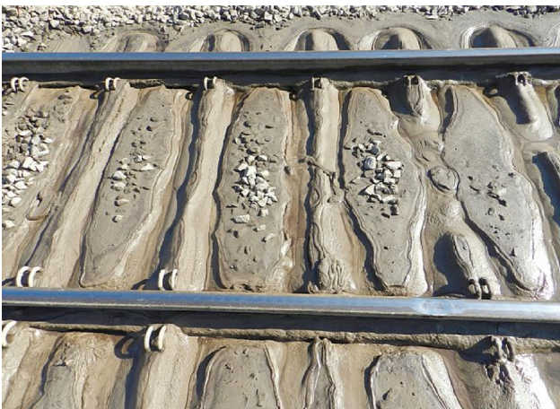
Rys. 7. Gniazdo wychłapek w źle odwodnionym torze [fot. ze zbiorów IK]
