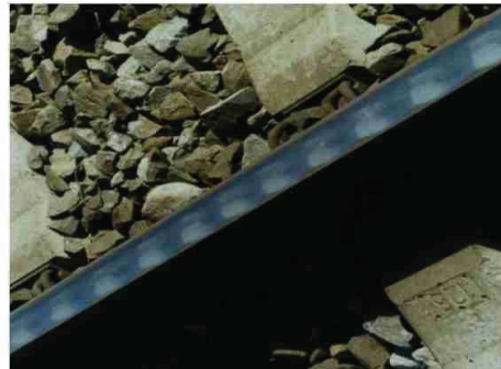
Rys. 3. Kształt powierzchni toczonej szyny począwszy od nowej szyny, po eksploatacji, szlifowaniu i ponownej eksploatacji (z lewej) {12} oraz fale poślizgowe na niedociążonej szynie włuku toru {13}
