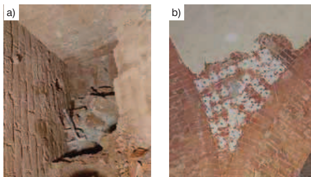
Rys. 5. Sposoby napraw stref podporowych sklepień: a) przemurowanie, b) iniekcja
