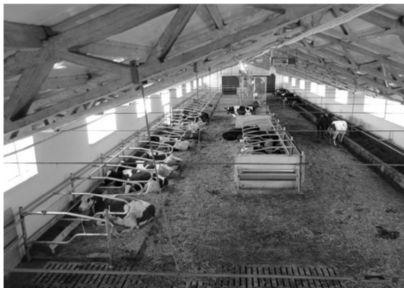
Fot. 2. Widok wnętrza obory po modernizacji
