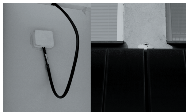
Rys. 6. Czujnik temperatury zamontowany na tylnej ścianie modułu PV oraz czujnik promieniowania słonecznego w płaszczyźnie modułów PV.
