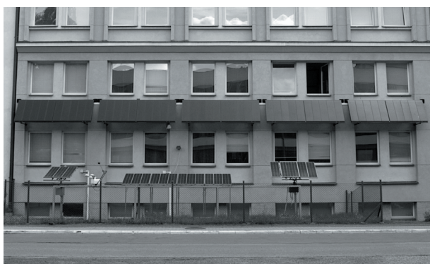
Rys. 1. Fasadowa elektrownia słoneczna 2kWp i ogródek fotowoltaiczny. Fig. 1. 2kWp BIPV- facade and the „solar garden”.
