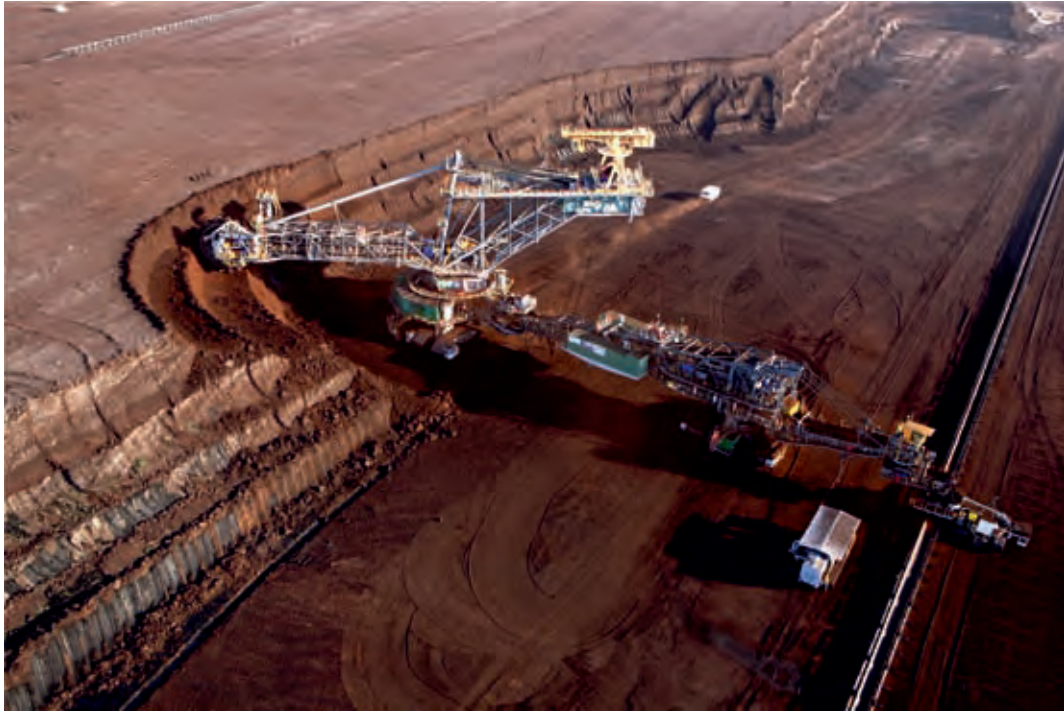
Rys. 1. Kopalnia Węgla Brunatnego Bełchatów, koparka 38- SRs 2000 Fig. 1. Bełchatów Coal Mine, excavator 38- SRs 2000
