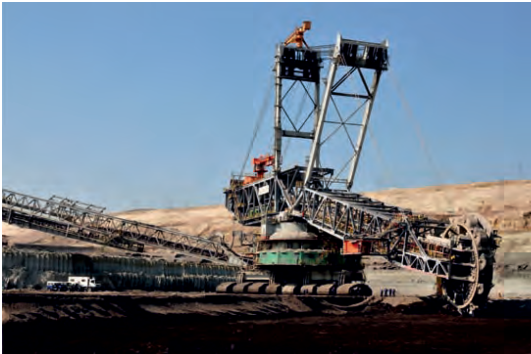
Rys. 2. Kopalnia Węgla Brunatnego Bełchatów, koparka 41- SchRs 4600x50 Fig. 2. Bełchatów Coal Mine, excavator 41- SchRs 4600x50
