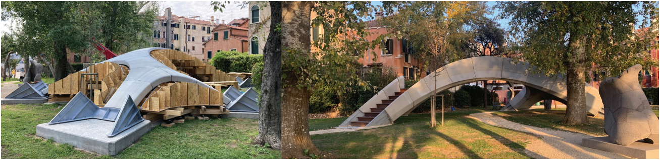
Fot. 2. (a) Striatius Bridge w trakcie realizacji, fot. Alessandro del Endice [4] (b) zdjęcie gotowego mostu, fot. Kamila Wilk, autor: Zaha Hadid Architects + Block Research Group
