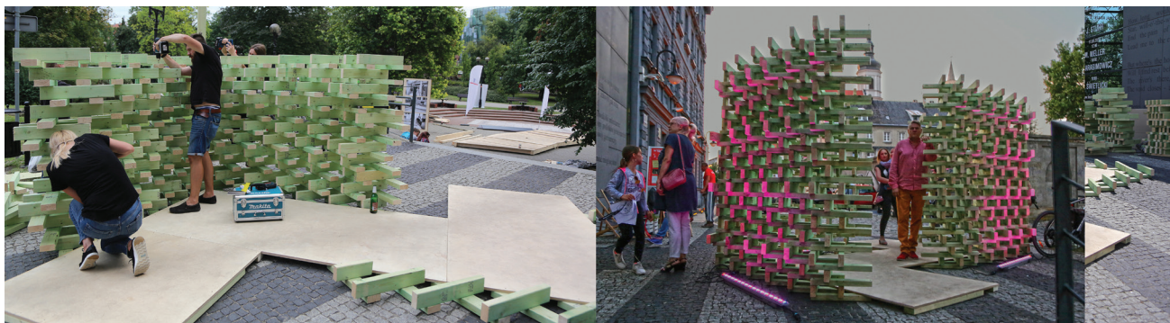
Fot. 8. (a) proces wznoszenia pawilonu F, (b) gotowy pawilon przed biblioteką w Opolu, fotografie udostępnione dzięki uprzejmości Opolskiej Okręgowej Izbie Architektów
