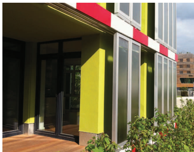
Rys. 1. Elektrownia w szklanych okiennicach
