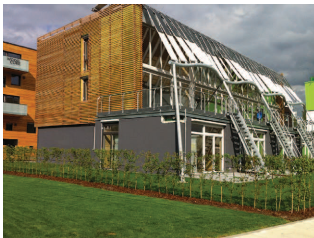
Rys. 3. Południowa fasada z ruchomymi membranami osłaniającymi tarasy
