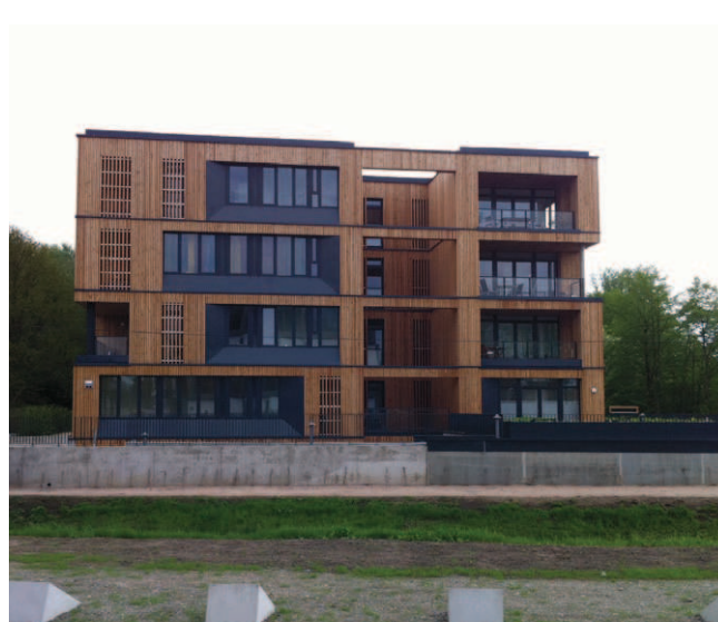
Rys. 7. Nisze w budynku hybrydowym, które pełnią funkcję tarasów dla mieszkańców, i balkonów dla firm
