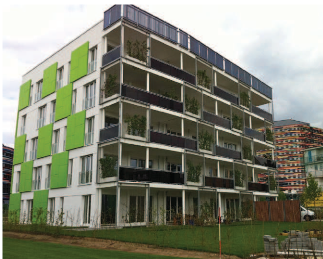
Rys. 2. Fasady budynku z PCM oraz panelami fotowoltaicznymi na balkonach i dachu
