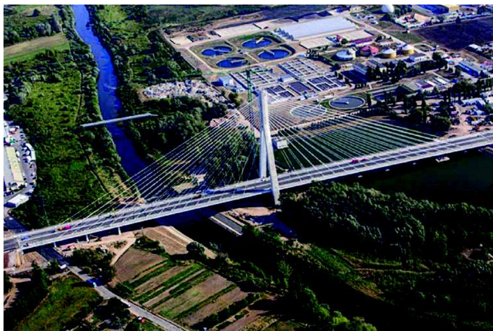
Fot. 4. Nowy most podwieszony przez Wisłok i zbiornik EC w Rzeszowie
