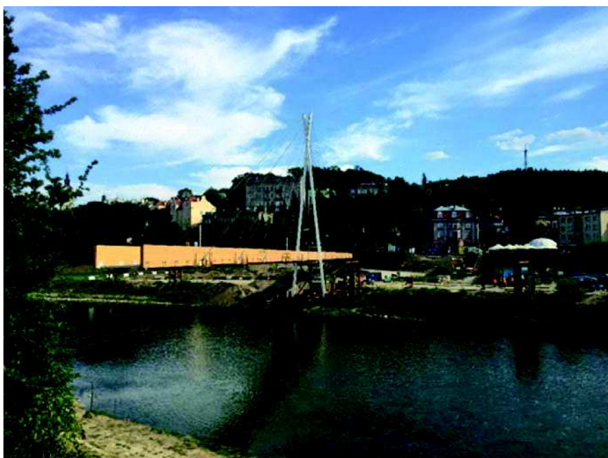
Fot. 8. Kładka z drewna klejonego przez San w Przemyślu podczas montażu metodą obrotu
