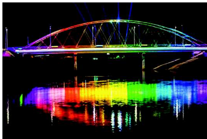
Fot. 5. Most łukowy typu network arch przez Wisłok w Rzeszowie (iluminacja nocna)
