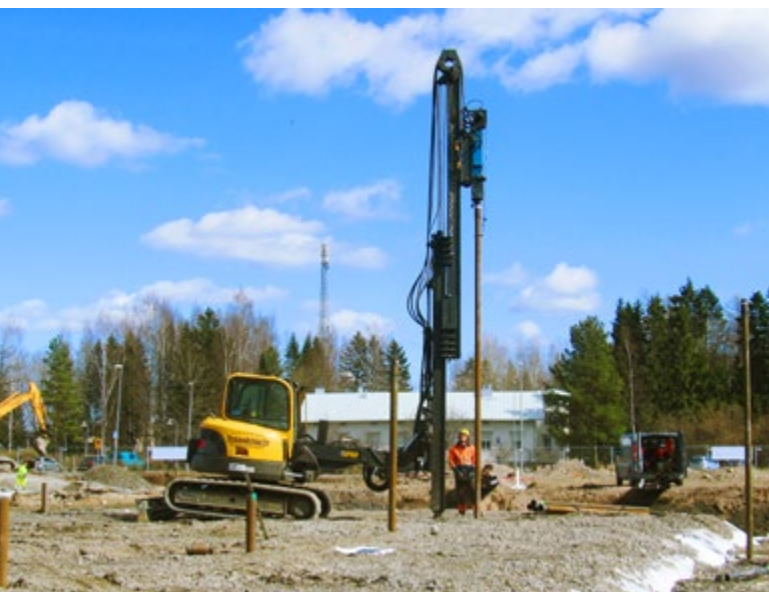
Ryc. 1. Proces palowania z wykorzystaniem lekkiego sprzętu był szybszy i łatwiejszy ze względu na mniejszą liczbę wykorzystanych elementów
