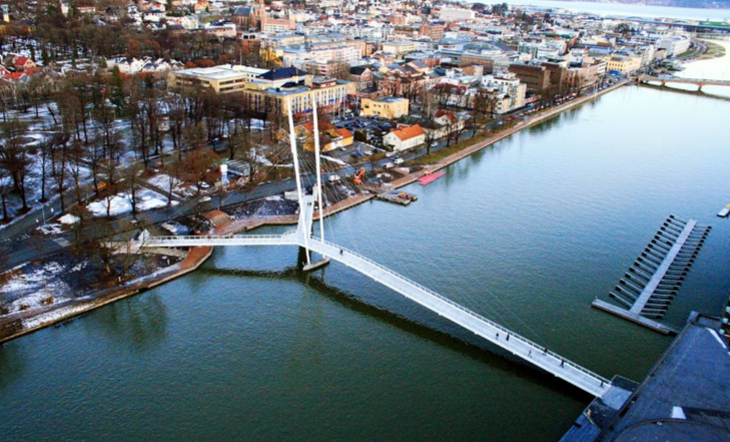
Ryc. 2. Kładka w Drammen, Norwegia, fot. Ruukki Construction Oy
