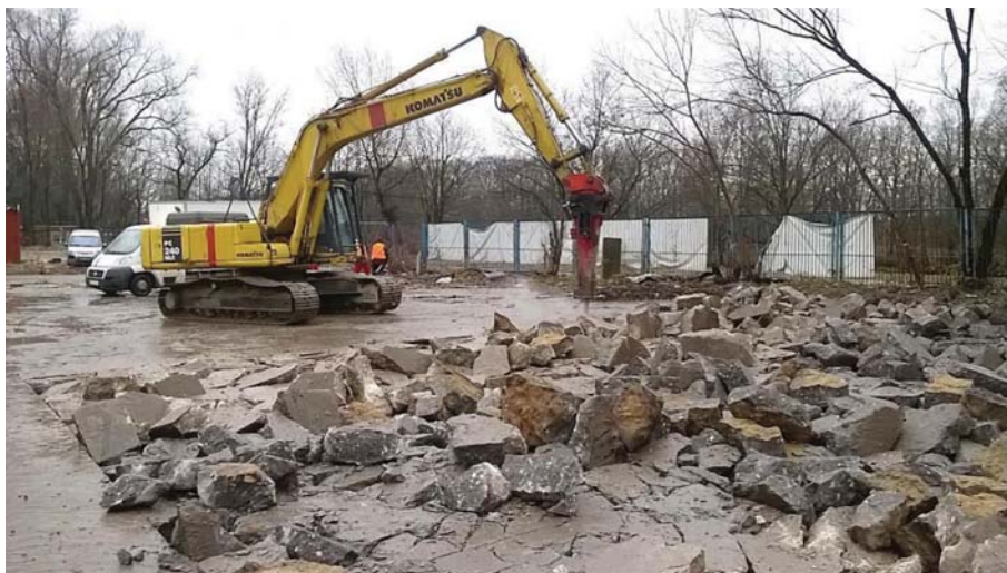
Rys. 5. Wstępne kruszenie nawierzchni betonowej przy użyciu młota wyburzeniowego
