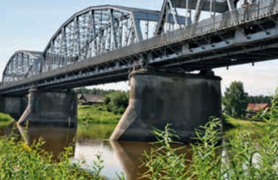
Stalowy, kratownicowy most łukowy przez Niemen w Mostach (obiekt nr 32)
