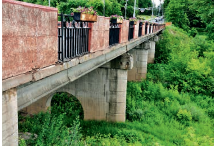
Betonowy most belkowy przez Połotę w Połocku (obiekt nr 27)
