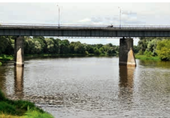
Stalowy most belkowy przez Niemen w Mostach (obiekt nr 33)
