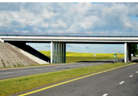
Betonowy wiadukt belkowy nad autostradą Witebsk – Połock (obiekt nr 26)
