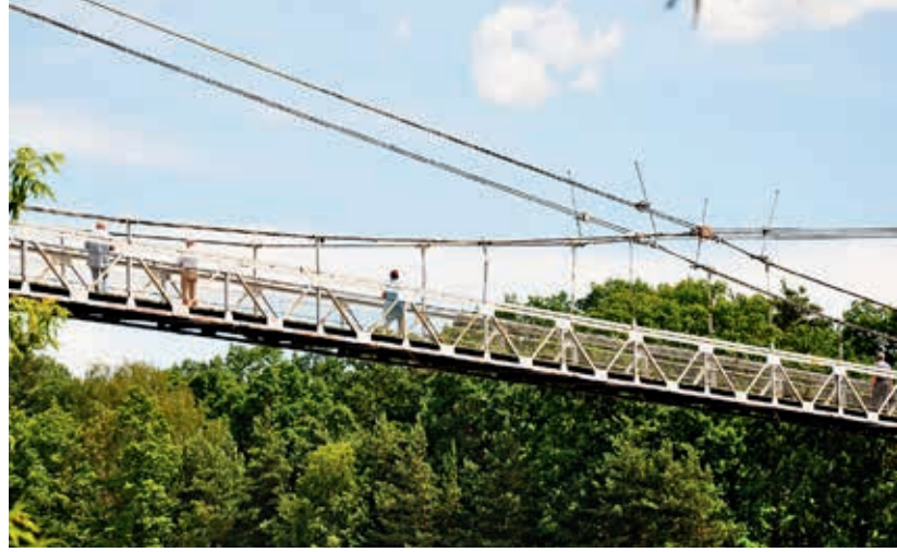
Pylon i wieszaki kładki – skrzyżowanie lin nośnych na kładce
