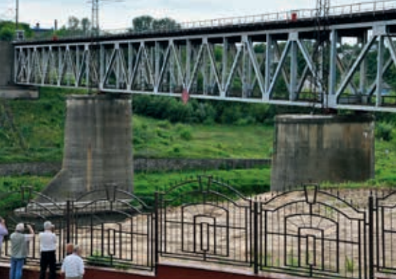
Stalowy, kratownicowy most kolejowy na filarach mostu Kierbedzia przez Niemen w Grodnie (obiekt nr 35)
