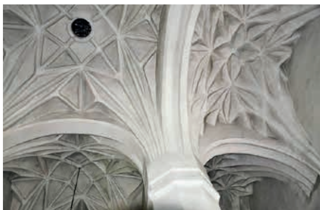
Sklepienie kryształowe w cerkwi obronnej w Murowance
