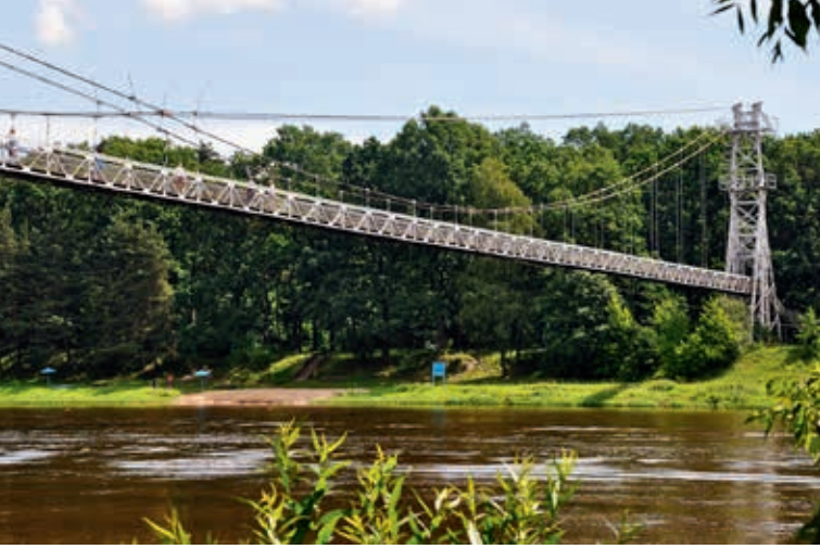
Stalowa kładka wisząca przez Niemen w Mostach (obiekt nr 34)
