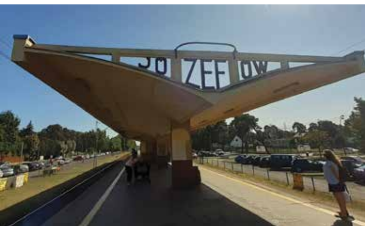
Il. 8. Stacja kolejowa Józefów na linii otwockiej - widok wiaty i poczekalni na peronie wyspowym. Fot. K. Dankiewicz, 2020
