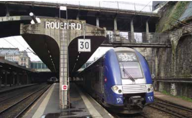
Il. 16. Stacja kolejowa Rouen-Rive-Droite w Rouen, we Francji. Betonowe zadaszanie peronu z 1928 r. Za: (dostęp 20.11.2020) https://fr.wikipedia.org/wiki/Gare_de_Rouen-Rive-Droite#/media/Fichier:Rouen_RD_Z_26500.jpg .
