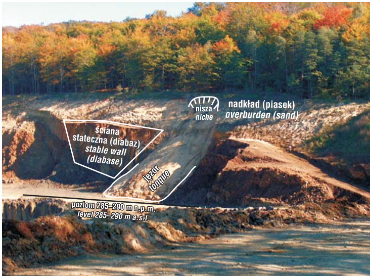
Ryc. 9. Osuwisko w nadkładzie nad ścianą skalną w kamieniołomie diabazu Fig. 9. Slide of the overburden above the rock wall in the diabase quarry
