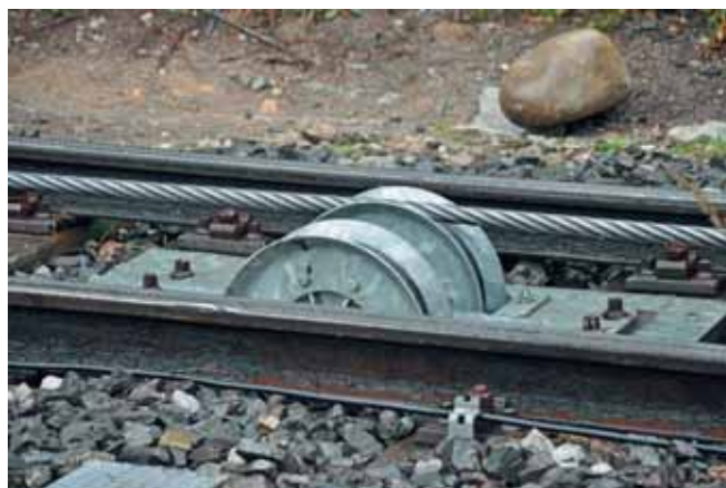
Ułożyskowane rolki liny napędnej na odcinku prostym (18.09.2013 r.) fot. Marek Graff
