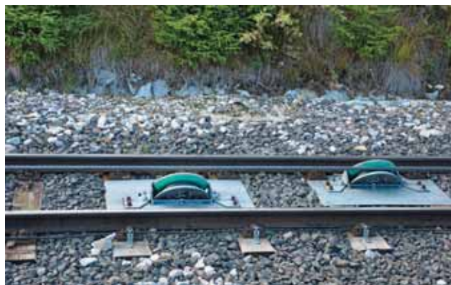
Ułożyskowane rolki liny napędnej na odcinku łukowym (18.09.2013 r.) fot. Marek Graff
