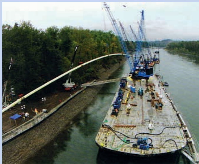
Ryc. 3. Operacja wprowadzania 36-calowego (91,44 cm) rurociągu stalowego [1]
