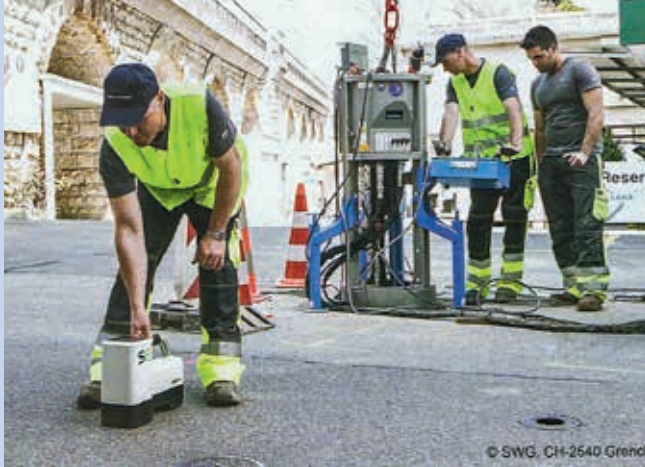
Ryc. 4. Wykonywanie przyłącza metodą Keyhole, na zlecenie SWG Grenchen w Szwajcarii [4]
