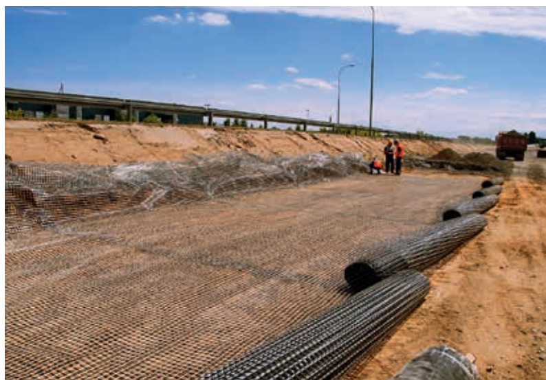
Stabilizacja gruntu geosiatką, fot. ViaCon Polska Sp. z o.o.
