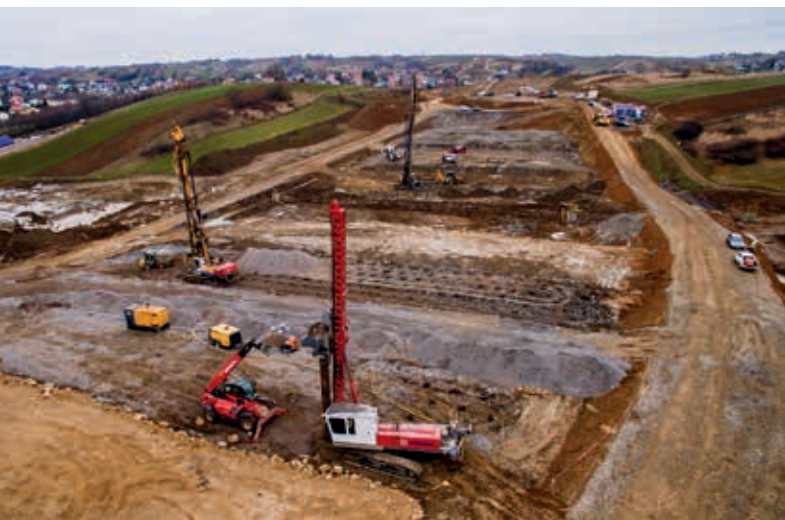
Wzmocnienie podłoża w technologii kolumn żwirowych S.C. oraz kolumn betonowych CMC, fot. Menard Polska Sp. z o.o.
