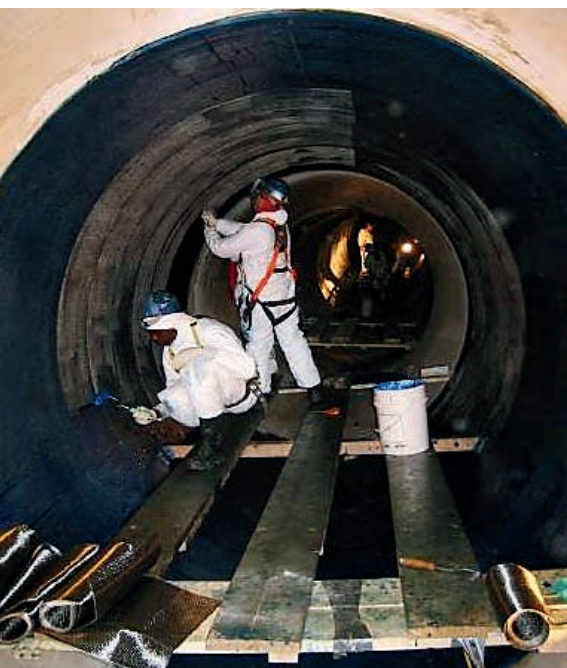
Ryc. 6. Zastosowanie tkanin węglowych w rehabilitacji magistrali wodociągowej [5]
