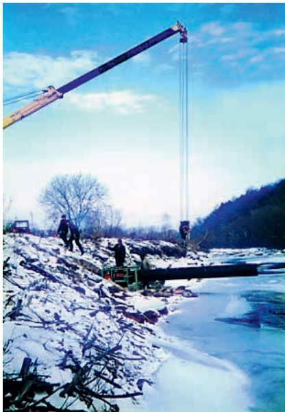
Ryc. 3. Długie odcinki rur PE-HD firmy Rurgaz wprowadzane do wnętrza nieszczelnego kolektora od jego wylotu do rzeki, fot. A. Kuliczkowski
