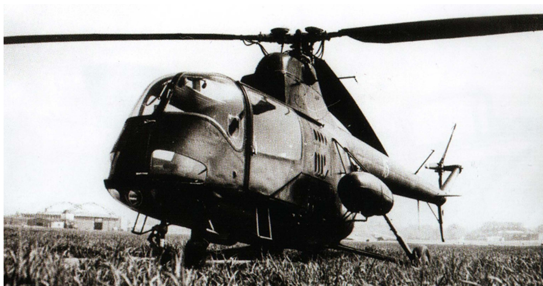
Rys. 4. Śmigłowiec SM-2 o powiększonej kabinie podczas badań w Instytucie Lotnictwa
