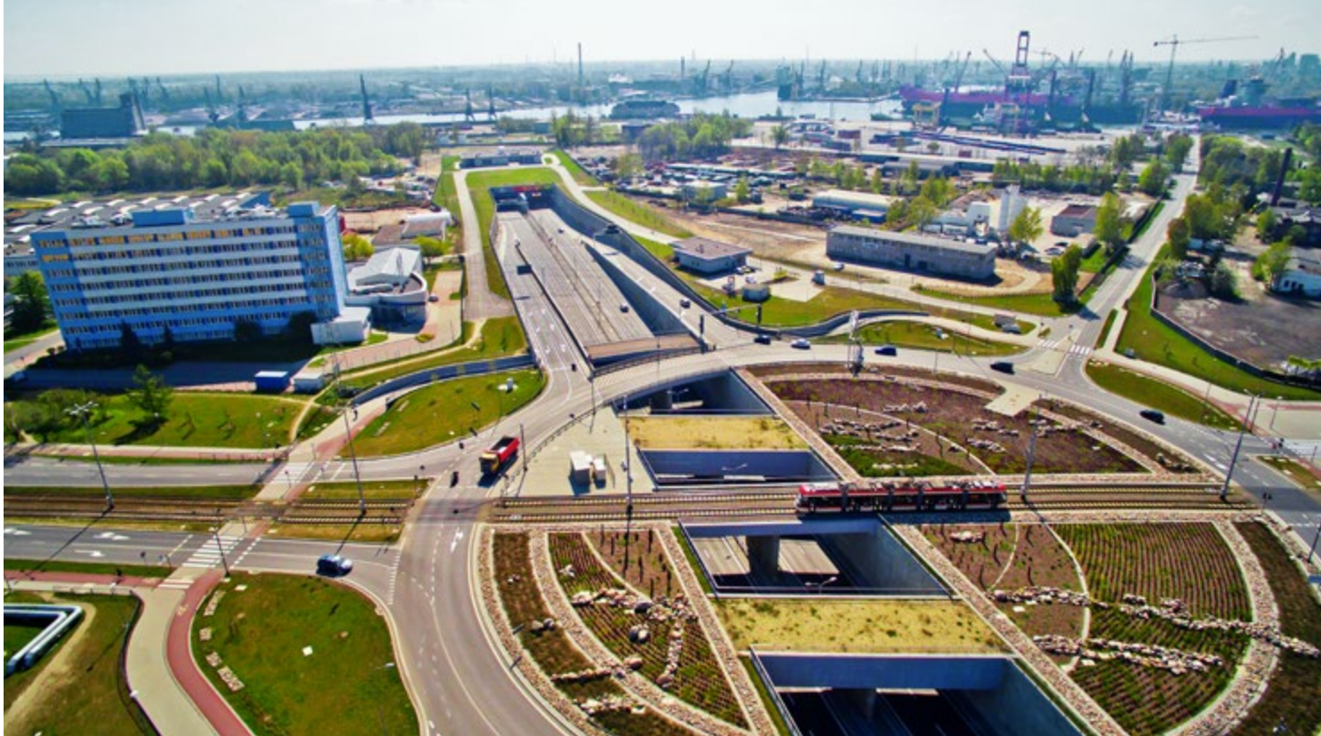
Widok na tunel pod Martwą Wisłą, fot. Gdańskie Inwestycje Komunalne Sp. z o.o.
