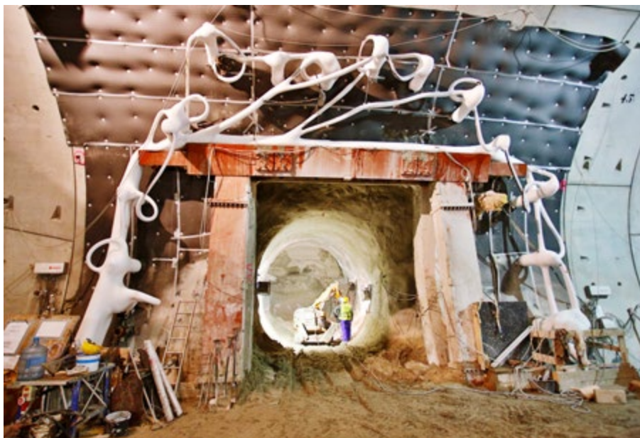
Mrożenie i wykonywanie przejścia poprzecznego w tunelu, fot. Gdańskie Inwestycje Komunalne Sp. z o.o.
