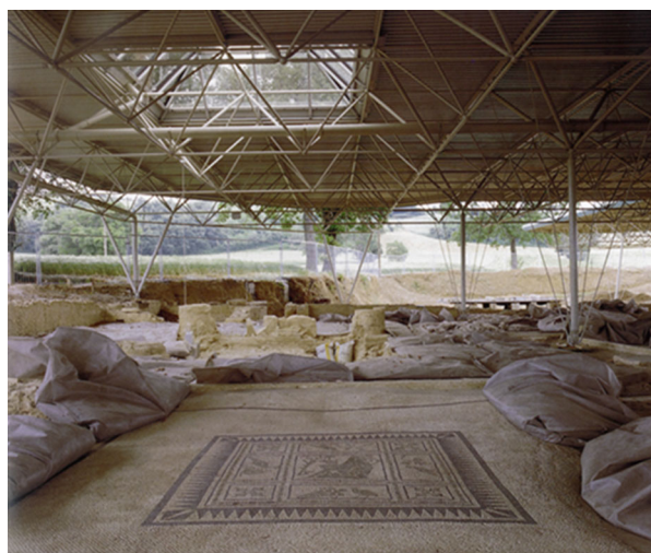
Ryc. 9. Domus romana in Castellone di Suasa, materiał: miedź oksydowana, świetliki nad mozaikami i atrium wykonano ze szkła, listwy dystansowe wykonano z drewna jodłowego, zastosowano drenaż w wodoszczelnych płytach miedzianych oraz izolację termiczną, projekt arch. Nazzareno Petrini – Studio Petrini Solustri & partners, źródło: https://copperconcept.org/it/riferimenti/copertura-della-domus-romana-castelleone-di-suasa
