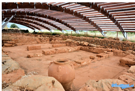
Ryc. 7. Osłona o drewnianej konstrukcji rozpięta nad relikwami pałacu minojskiego w Malii na Krecie, przykład prawidłowych rozwiązań stosowanych do panujących warunków klimatycznych i specyfiki materiału zabytkowego (cegła suszona), źródło: E. Danzi, Metodologie di indagine. La schedatura delle coperture archeologiche: alcune riflessioni sull'impostazione metodologica del progetto , [w:] Archeologia e Contemporaneo , (red.) A. Indrigo i A. Pedersoli, Università luav di Venezia, luav 81, Venezia 2010
