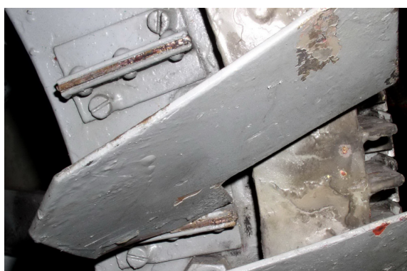
Rys. 3. Zerwanie łopatki wentylatora przymocowanego do korpusu wirnika [2, 3]
