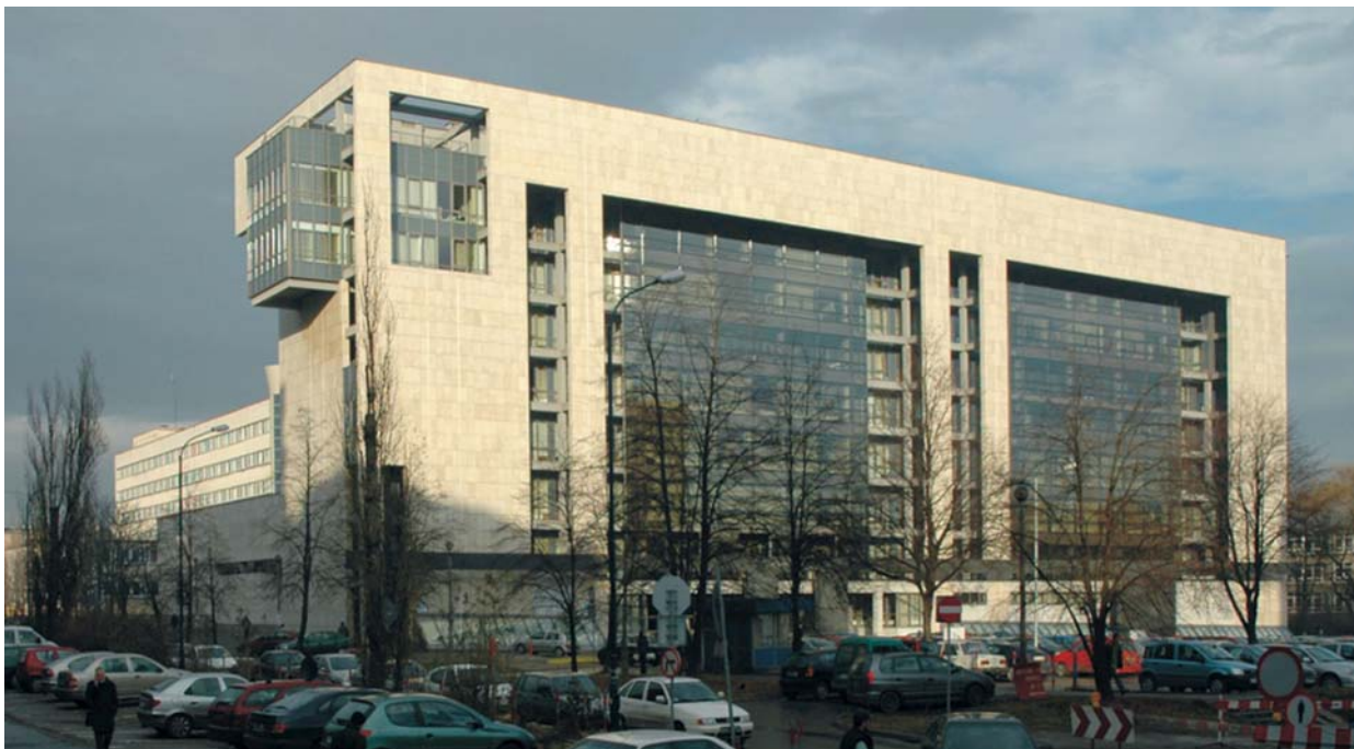
Ryc. 14a. Południowe skrzydło Sądu Okręgowego Fig. 14a. Southern wing of the Regional Court
