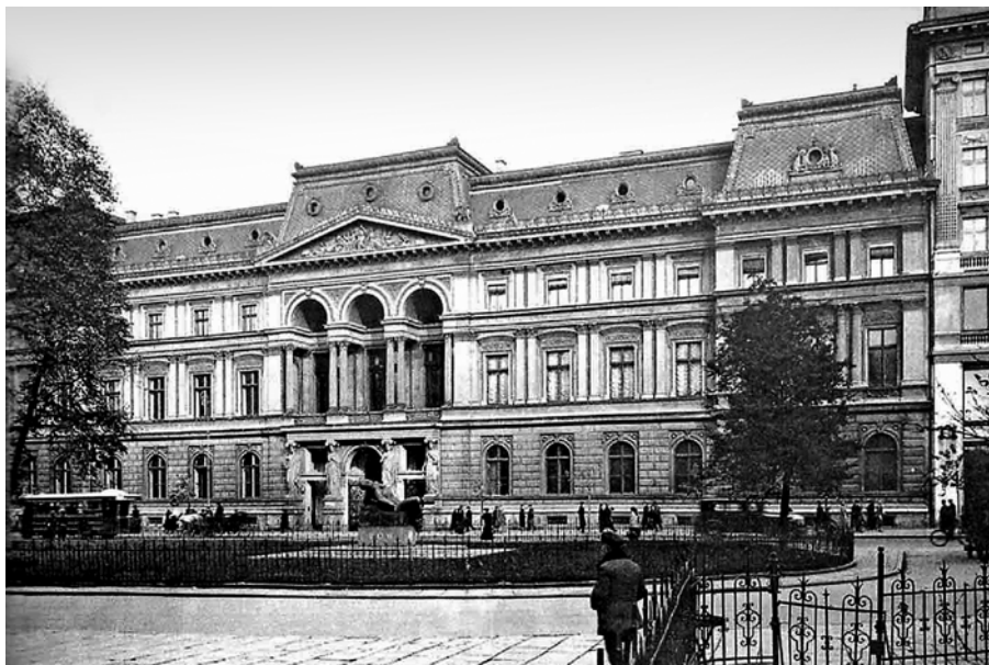
Ryc. 12. Pałac Kronenberga. Warszawa. F. Hitzig, 1867–1871 Fig. 12. Kronenberg Palace. Warsaw. F. Hitzig, 1867–1871
