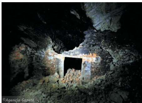
Rys. 2. Wejście do jednej ze sztolni technicznych w Rudkach (autor nieznany – archiwum PIG-PIB)
