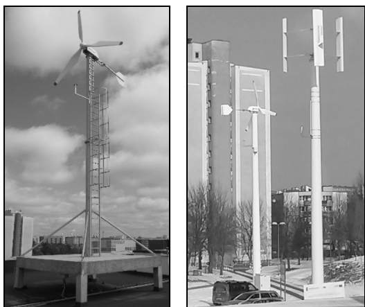
Rys. 2. Widok badanych elektrowni wiatrowych
