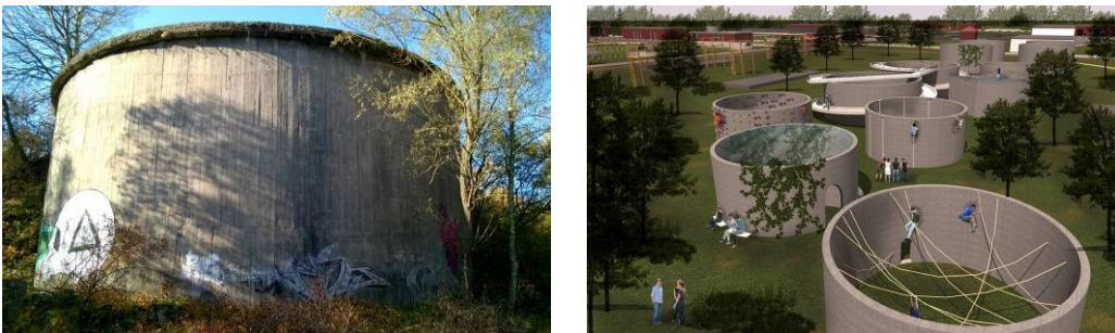
Ryc. 6 Po lewej stronie jeden z silosów znajdujących się na obszarze byłej fabryki, po prawej propozycja zmiany w przestrzeń użytkową istniejących silosów. Źródło: [2]
