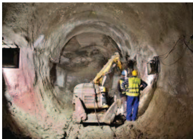
Rys. 4. Drążenie przejścia poprzecznego w zamrożonej bryle gruntu za pomocą robota wyburzeniowego BROKK 330
