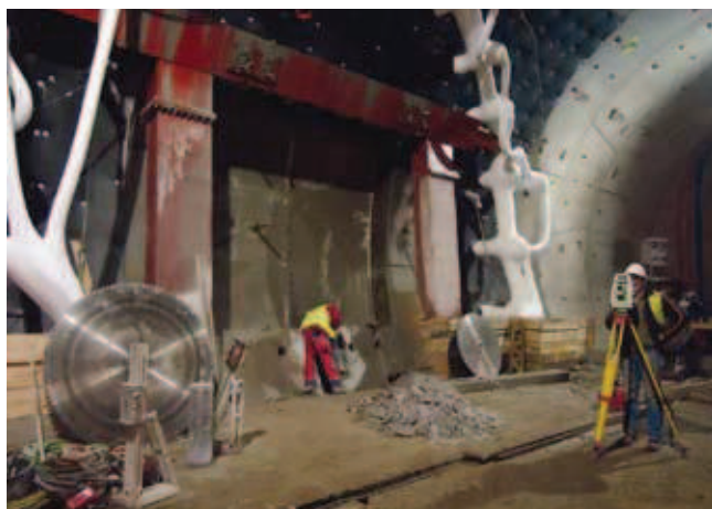
Rys. 3. Stalowa rama wzmacniająca
