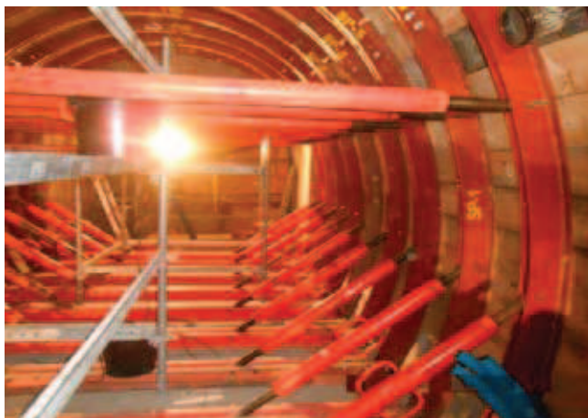
Rys. 6. Szalunek obudowy docelowej przejścia poprzecznego
